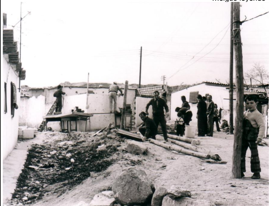
Foto de 1976 construyendo la Asociación de Torregrosa, construyendo un barrio
